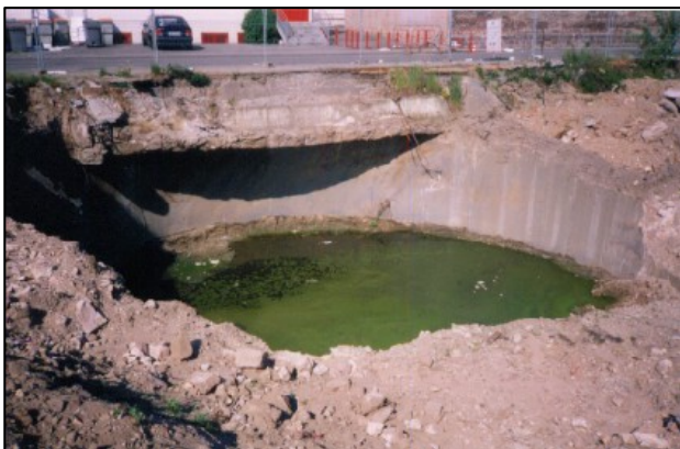
Les fondations d'un des gazomètres
